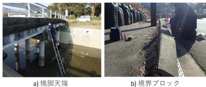
図 6 現場での試行状況
