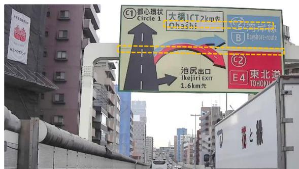
図-7 標識板のシートめくれ調査
