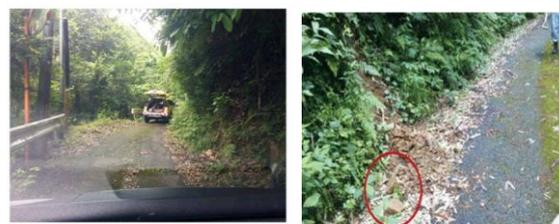
写真 1, 2 市道山岳部の状況 (画像のみでは路面確認不能な落葉や、危険な落石等)
