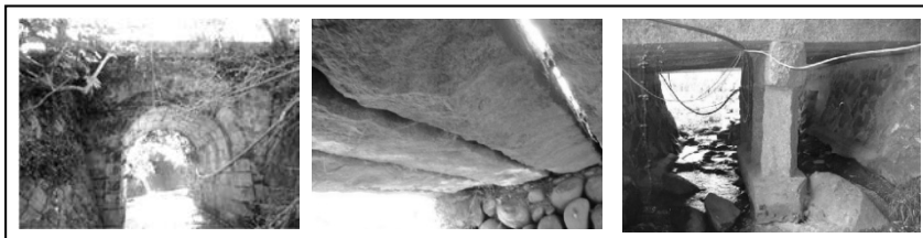
図 1、上部構造での石材使用例
