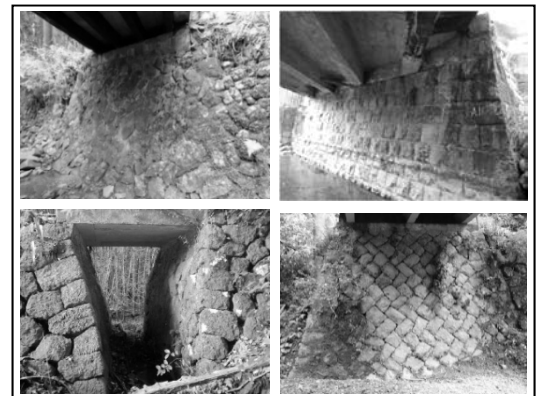
図 5、石積護岸を下部構造に兼用した例
