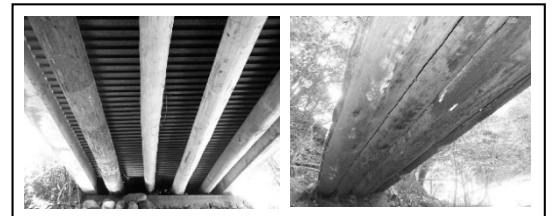
図 2、上部構造での木材使用例
