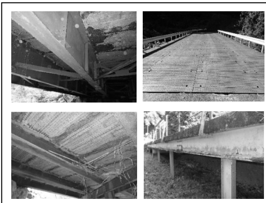
図 3、工事用仮橋の転用例
