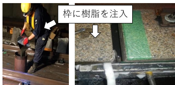
図3 突起補修(左) 下面補修(右)
