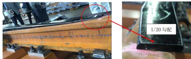
図2 横取り材主材の断面増加
