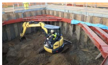
写真-2 掘削状況
