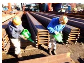
写真-4 止水材塗布
