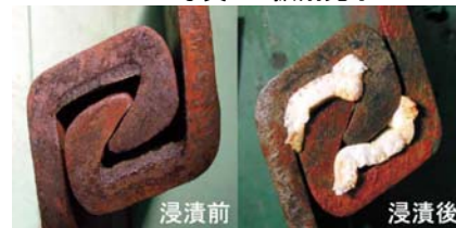
写真-5 止水材塗布前後
