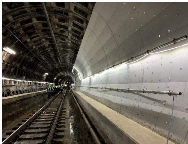
写真2 側部補強構造
