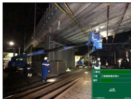
写真-5 点検状況 (A)
