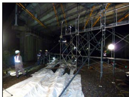
写真-3 足場仮設状況(A)
