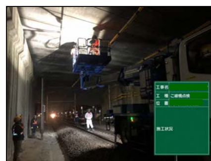
写真-7 点検状況 (B)
