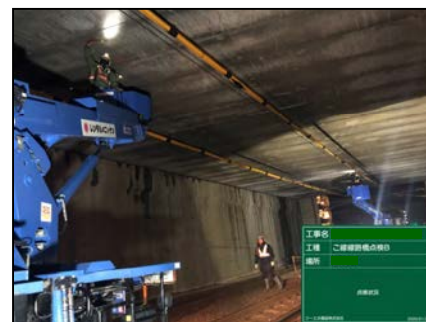
写真-6 点検状況 (B)
