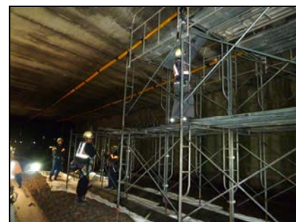
写真-4 足場仮設状況(B)
