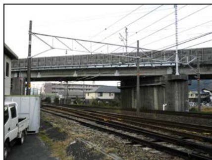
写真-1 A こ線線路橋
