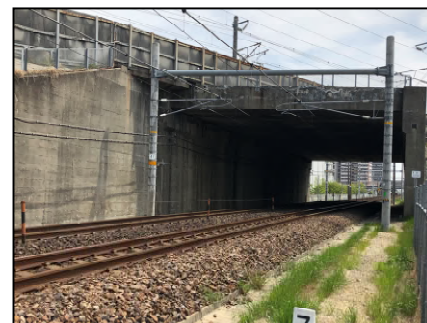
写真-2 B こ線線路橋
