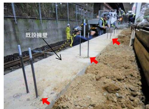
図3. 既設擁壁に先行設置されたアンカー (赤矢印)
