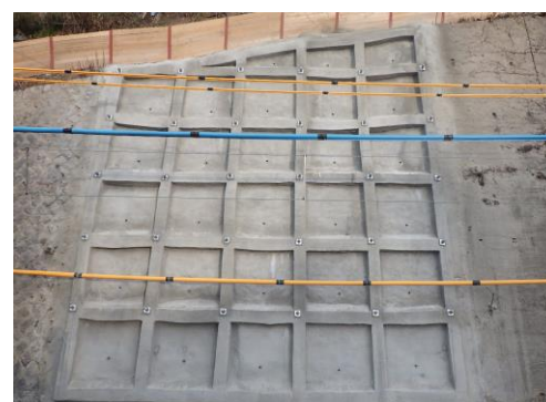
写真-3 復旧完了全景
