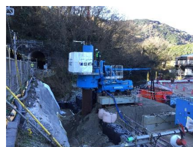
写真 2 鋼管杭打設状況
