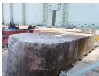
写真-5 沓座切断完了
