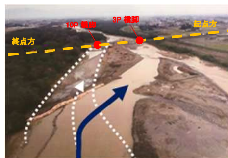
写真-3 河川の瀬替え状況
