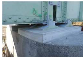
写真-7 沓座新設
