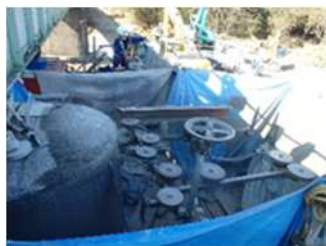
写真-4 沓座切断状況
