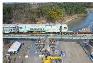
写真-6 プレロード試験状況
