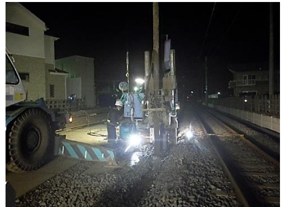
図-1 WJ 併用鋼矢板圧入状況（夜間作業）
