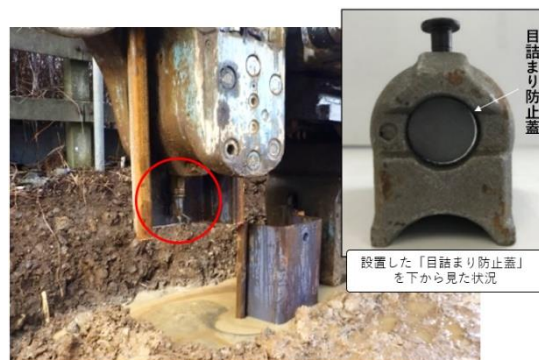
図-4 目詰まり防止蓋設置状況図
