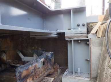
写真-3 支点部構造（仮設時）
