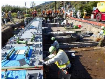
写真-5 新設桁横取状況
