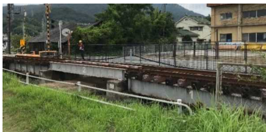
写真 - 2 江戸堀川橋りょう全景（海側より）
