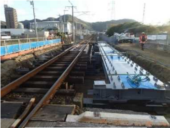
写真 - 4 取替直前
