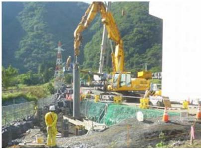
写真1 杭孔の削孔状況
