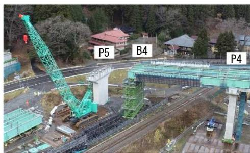
写真2 P4-B4架設完了(夜間施工)
