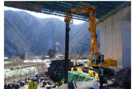
写真3 支持杭の引抜き状況
