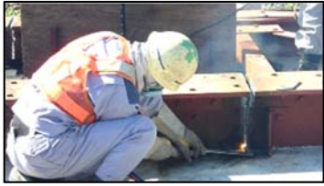
写真-2 切断状況 (ガス切断機)
