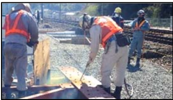
写真-1 切断状況 (ランス棒)
