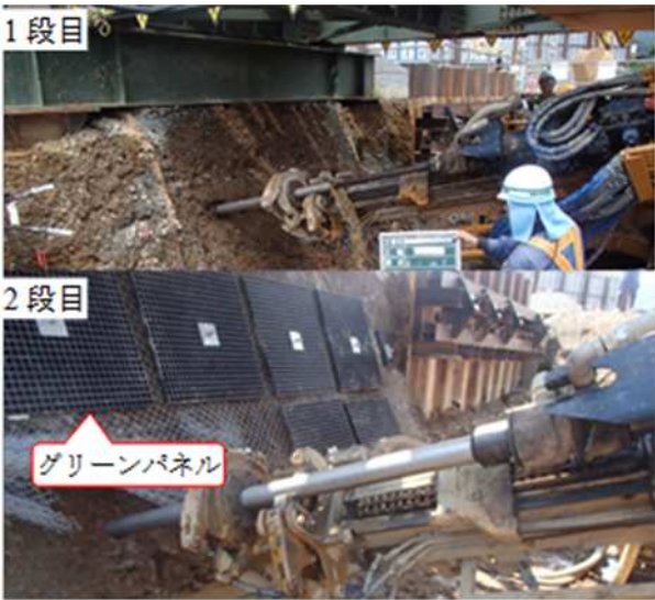
写真-1 ロックボルト施工写真
