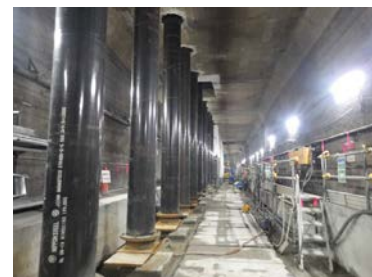
写真-1 ガイド管設置状況 (躯体内部より撮影)
