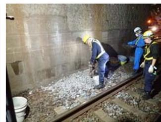
写真-6 陥没後復旧
