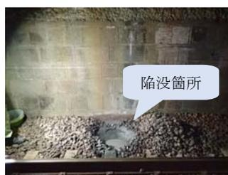
写真-5 陥没状況
