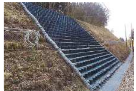
写真-3 テラセル擁壁工
