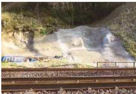
写真-1 モルタル吹付工
