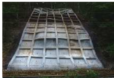
写真-2 吹付格子砕工
