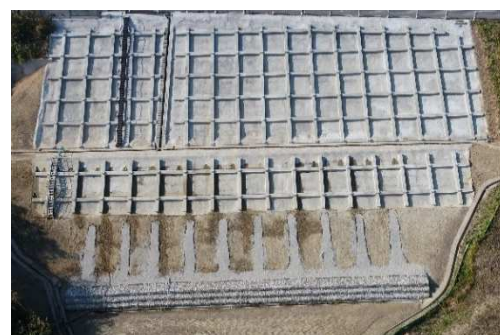
写真4 盛土①施工状況
