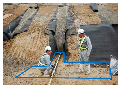
写真3 砕石縦排水工施工中湧水状況
