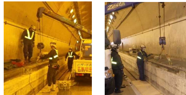
写真-3 天端コンクリート撤去状況
