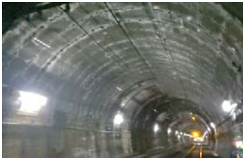
写真-1 漏水防止板設置状況
