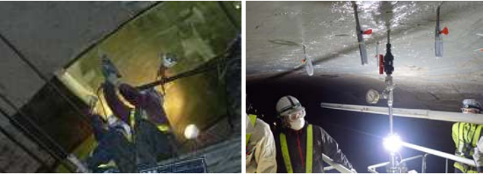
写真 - 1 AAA 工法
