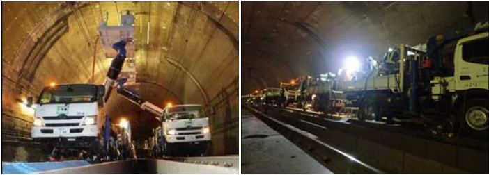
写真 - 3, 4 JETMS 工法（軌陸車使用）
