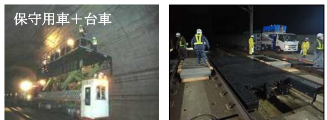
写真 - 5 保守用車使用
