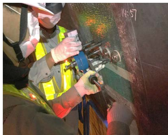
写真-3 付着試験状況
