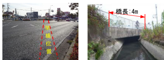
写真-1 小規模橋梁(RC床版橋)の架橋状況
