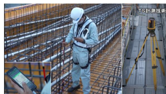
図-6 人員1名による PC ケーブル配置計測
