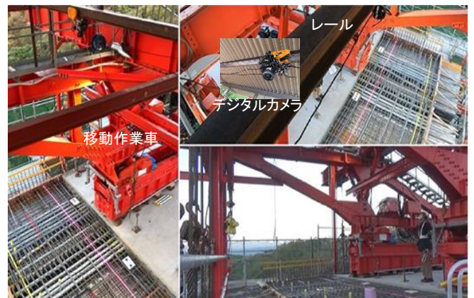
図-2 画像解析検査用配筋撮影設備
