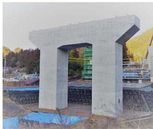
図 2 CIM による躯体完成図及び完成躯体
