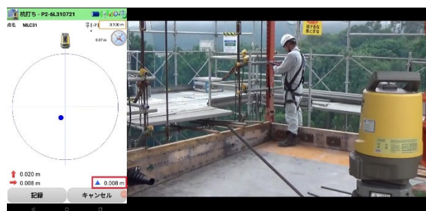
図9. TS計測器による型枠セット作業
