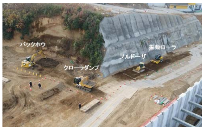
図4 実証実験状況
