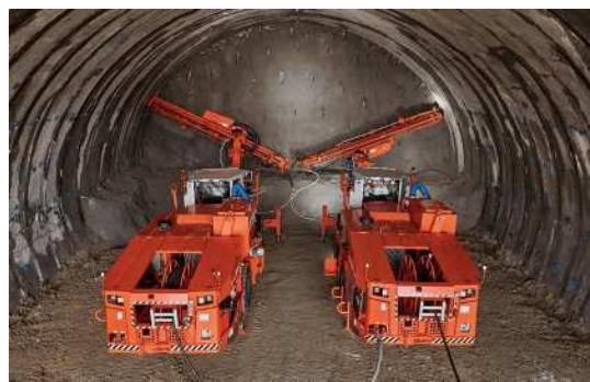
図-1 ロボルト施工状況
