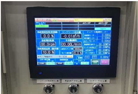
写真-2 吹付リアルタイムモニター画面
