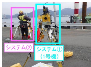
写真－3 鋼管杭誘導状況
