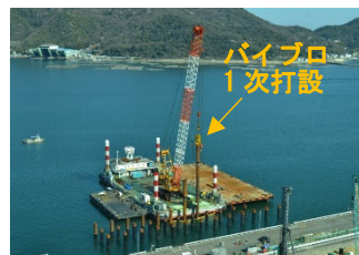
写真－2 鋼管杭打設状況
