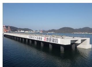
写真－10 プレキャスト 栈橋架設完了
