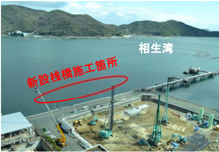
写真-1 施工箇所
