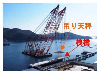
写真－5 プレキャスト架設
