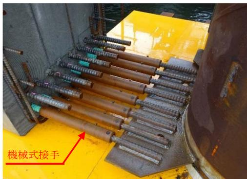
写真-1 機械式接手（モルタル充填式）
