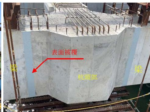
写真-3 打継部の表面保護材
