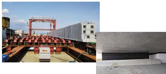
写真-2 桁受架台設置状況および支承部（架設後）
