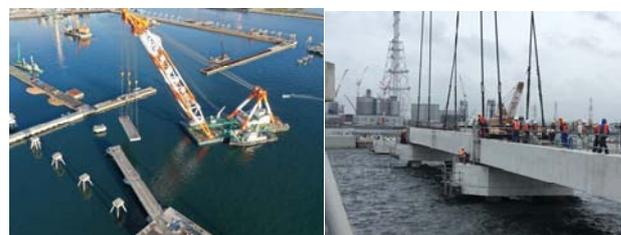
写真-3 一括架設状況および据付状況
