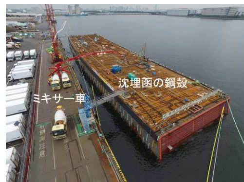
写真-2 浮遊打設の様子(千葉県船橋市)
