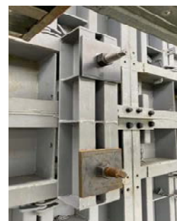
写真-1 セパレータ（アンカーボルト）
