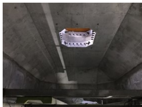
写真-2 型枠支保工解体時の上床版 (σ2)
