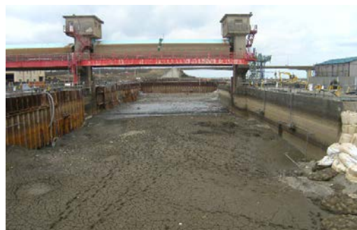
写真-4 仮締切内ドライアップ状況
