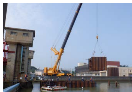
写真-2 ユニット式仮締切の施工状況
