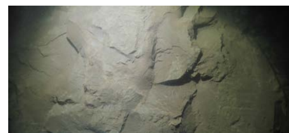
図-4 潜水土の撮影による岩盤画像例
