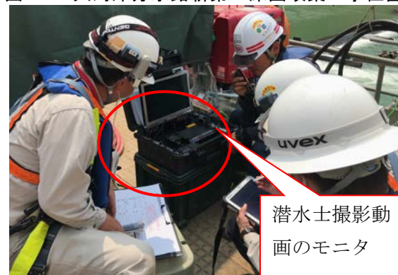
図-2 潜水土による撮影画像モニタ確認状況
