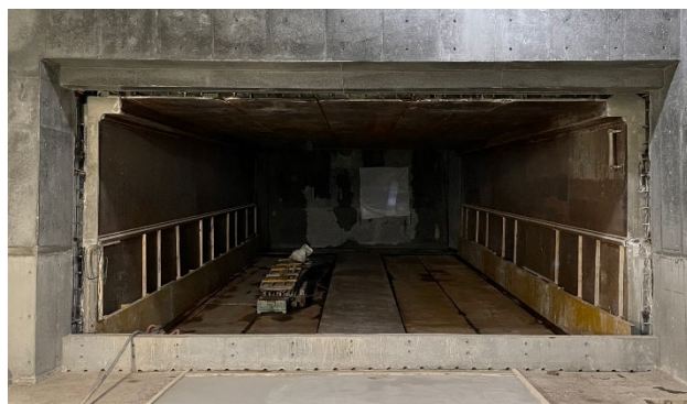
写真-2 連絡通路構築完了
