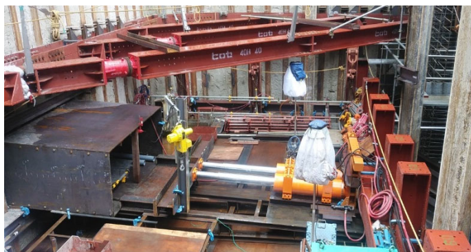
写真-1 エレメント推進状況
