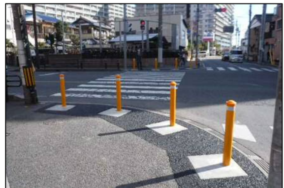
写真-2 ボラード設置完了箇所の状況
