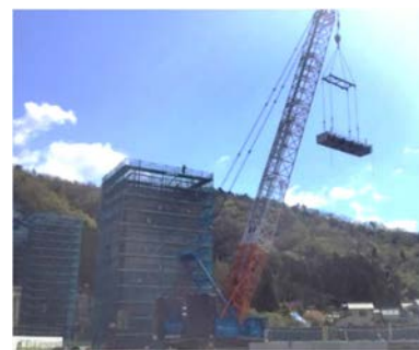
写真-1 施工状況
