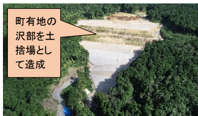
写真-1 トンネル工事の土捨場
