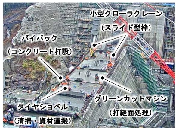
図-3 比較対象作業および使用重機
