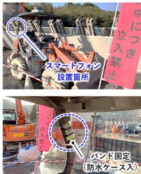
図-2 スマートフォン設置状況
