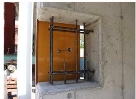
写真-6 配筋, 型枠観察箇所
