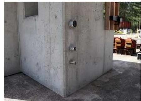
写真-8 シース管, PC 鋼棒
