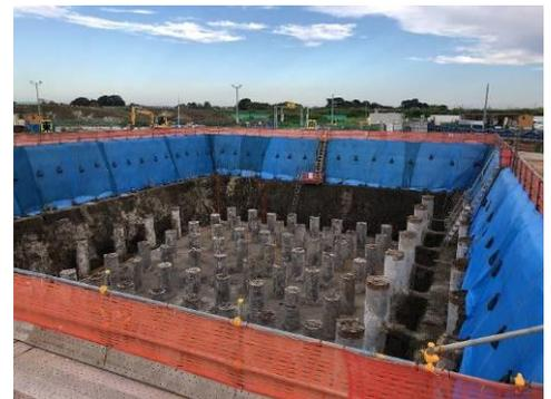
図-2 無支保工掘削状況
