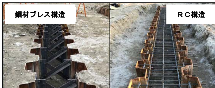
写真-1 頭部固定構造施工状況
