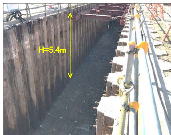
写真-3 掘削完了
